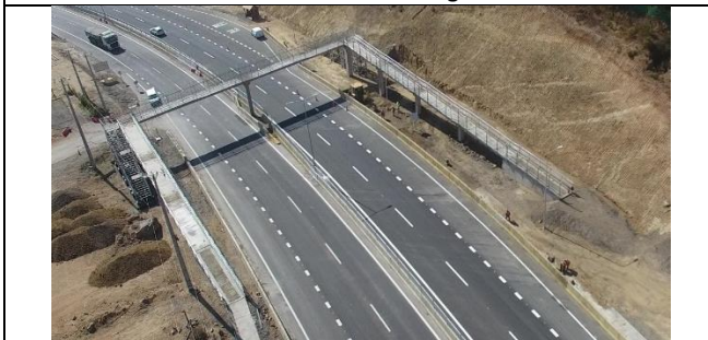
Pasarela N° 3 - Vista General.
