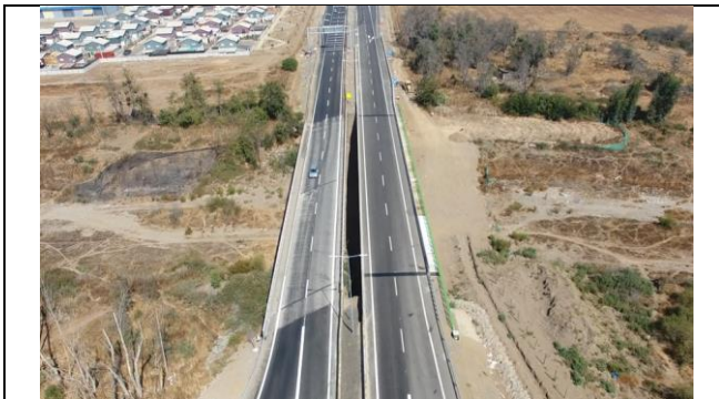
Puente Nogales – Vista general.
