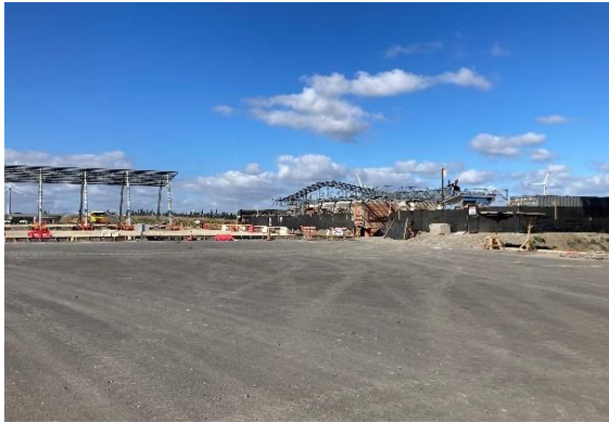
Ilustración N°1: Construcción Plaza de Peaje Renaico
