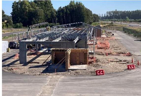
Ilustración N°2: Construcción Área de Servicios Grles.
