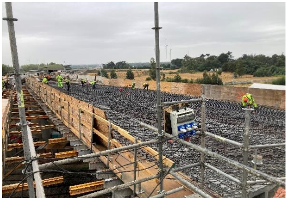
Ilustración N°3: Viaducto Caihue Tramo sobre FFCC
