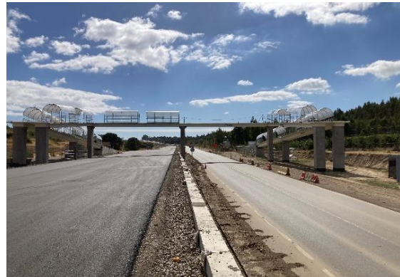
Ilustración N°4: Pasarela Santa Cecilia
