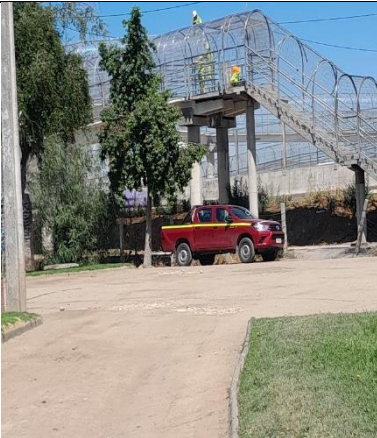
Reparación mallas antivandálicas- Rinconada
