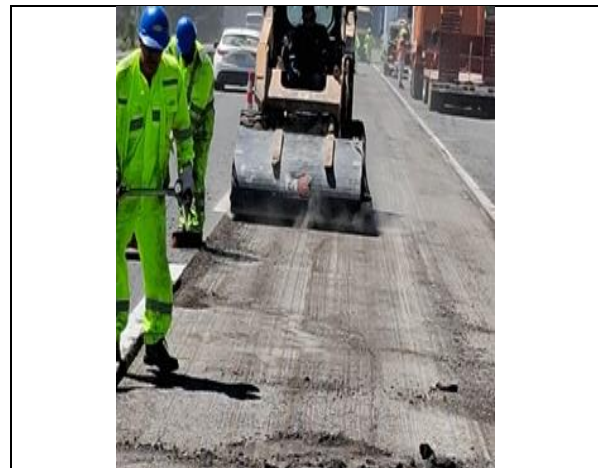
Mantenimiento de pavimentos- km.93,100- Desc.
