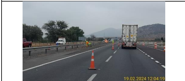
Reposiciones barreras metálicas- Km 54,300
