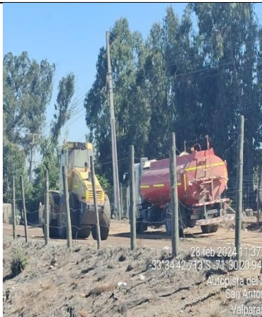
Mantención calles de servicio Norte Km 98,000
