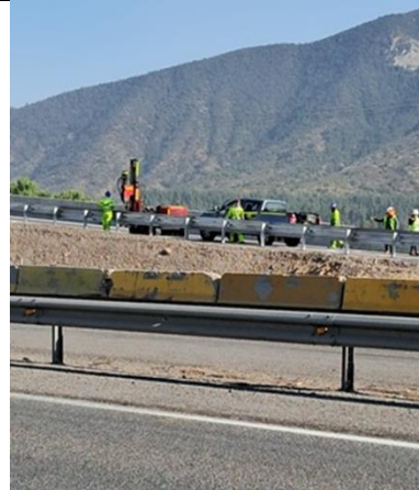
Instalación defensas – Km 54,720, Chiñigüe, Desc
