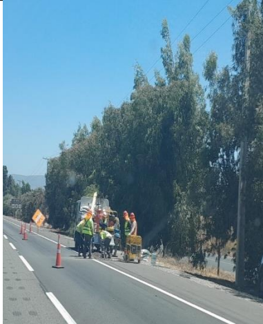
Bache en berma Km 42,000 Asc
