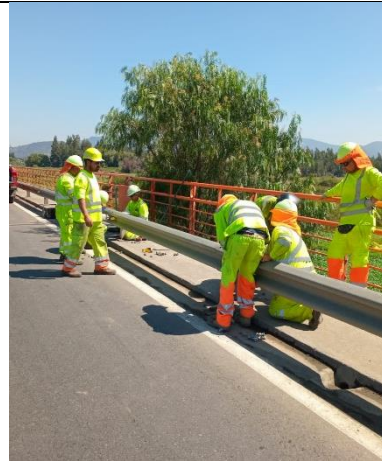
Reparación defensas Pte Manuel Rodriguez
