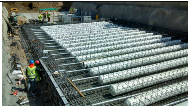
Cilindros de poliestireno Losa Aligerada Trinchera Vía Expresa
