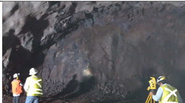
Túnel Mina N-S con roca Tipo IV
