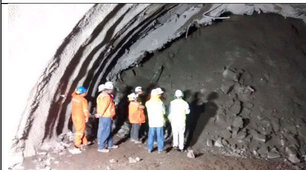
Derrumbe frente Túnel AVO N-S 12-12-18
