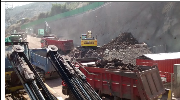
Carguío de Marina Túnel Mina AVO N-S
