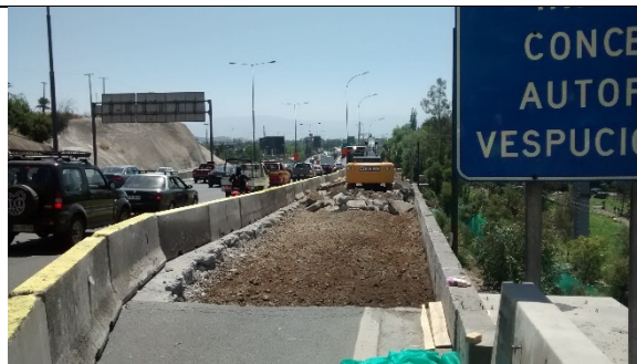
Demolición Pavimentos y Muros existente para ampliación Salida a C.E.
