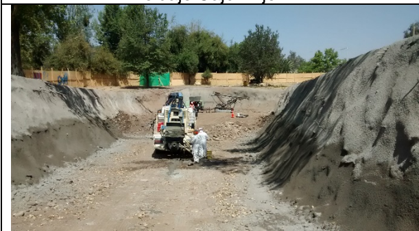
Profundización acceso Boca Sur
