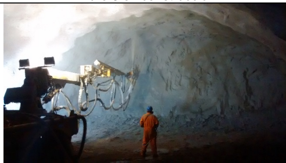
Proyección de shotcrete en Túnel Mina N-S
