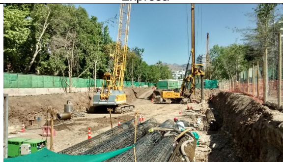
Perforación Pilotes Trinchera vías expresas Comuna Vitacura
