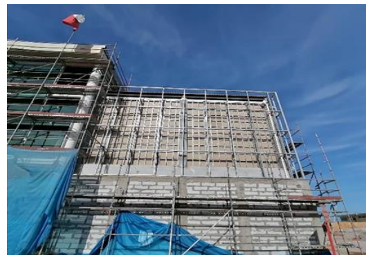
Forraje tabique de Fachada 2º Nivel Edificio PAX (Ampliación)
