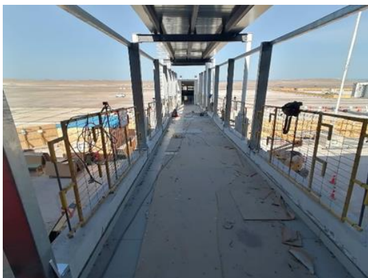
Instalación EM soporte barandas vidriadas, Puentes de Embarque N°5 y 6, Edificio PAX (Ampliación)
