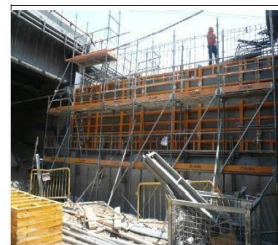
14.02.2020 Viaducto El Salto Estribo 1.- colocación de armadura y moldajes.
