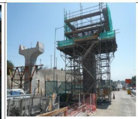
(20.02.2020), Cepa 13.- Se trabaja en armadura del Dintel.
