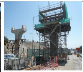
(20.02.2020), Ceba 13.- Se trabaja en armadura del Dintel.
