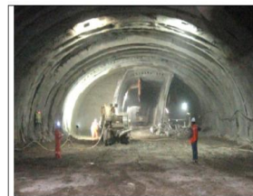
(12.02.20), Frente Sur Fase III. Vista general de la caverna. Se aprecian las tres fases de excavación parcial y los 2 hastiales temporales. Dm 2.621.
