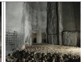
(26.02.20) obras Nudo Kennedy Excavación de estructura E-19. Se completa revestimiento de muros forro.
