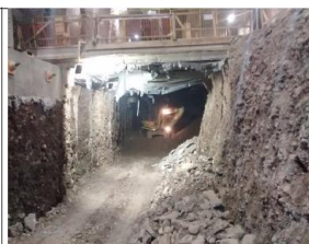
(26.02.20), Pique Losa 47 Nivel Intermedio - 1 (Dm 3.811,6): excavación bajo losa intermedia hacia nivel -2, a todo el ancho de la trinchera.
