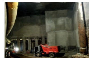
Estructura E-19 bajo Nudo Kennedy: muros forros completos para las paredes ponientes (20.04.2020).
