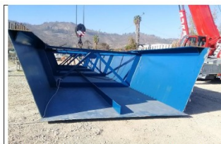
Fabricación y recepción de vigas metálicas del Viaducto El Salto en Maestranza.
