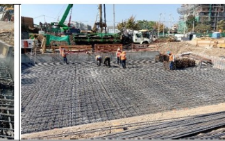
Losa Superior N°3 sector 1: Colocación de Hormigón (29.04.2020).
