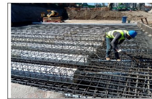
Losa Superior N°3 sector 1: Armadura y dispositivos del Postensado terminados para hormigón (28.04.2020).
