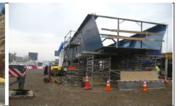
(22.06.2020), Viga 4: Bateas VP7 y VP8 alineadas y niveladas para soldadura de terminación en empalme en Unión Z.
