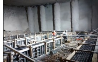
(04.06.2020) Trinchera 6.1. (Dm 5.039) Preparada para hormigonar primer nivel de vigas (estampidores) transversales.
