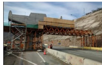
(30.06.2020) Cepa 15 Viaducto El Salto: Hormigonado el Dintel, se retira moldajes y estructura MK.
