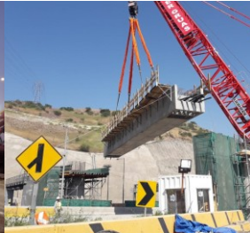
Infraestructura del Viaducto 3 montaje pórtico 25
