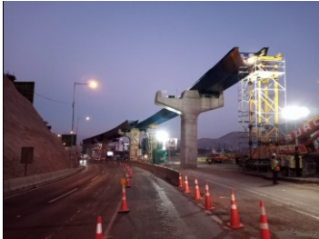
Viaducto El Salto montaje de vigas tramo 3 lado norte cepa 21.
