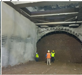
Túnel Híbrido - Ramal 257: túnel mina colocación de muro.
