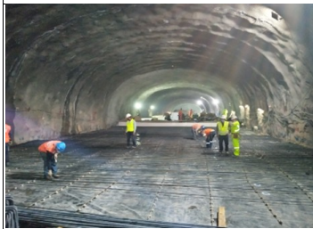
Túnel Híbrido - Ramal 256 Troncal Sur: en Losa N°58 colocación de armaduras.
