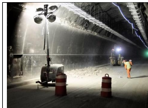
Desbaste coronamiento de Muro Hormigón, Túnel I
