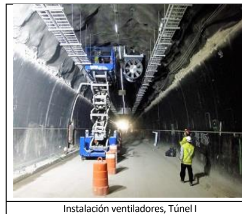
Instalación ventiladores, Túnel I
