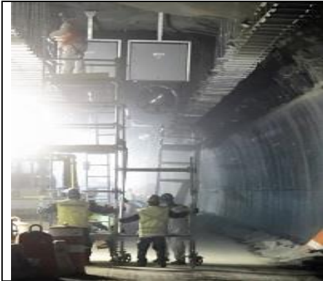
Estructura soporte ventiladores, Túnel I
