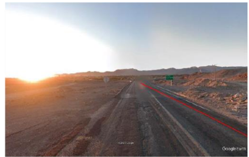
Inicio Concesión, Ruta 23Ch, km 0.0 aprox. Fuente: Google
