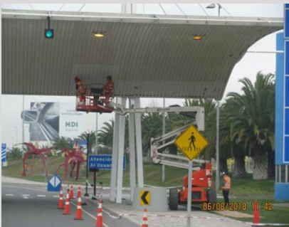
Labores de pintura en estructura de caseta de peaje manual en Km. 1,500 de Acceso Vial AMB
