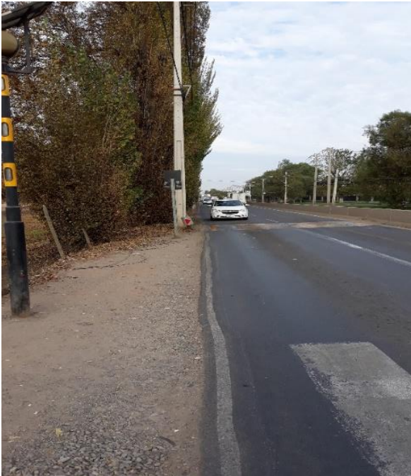
Limpeza y retiro de Basuras de la Faja
