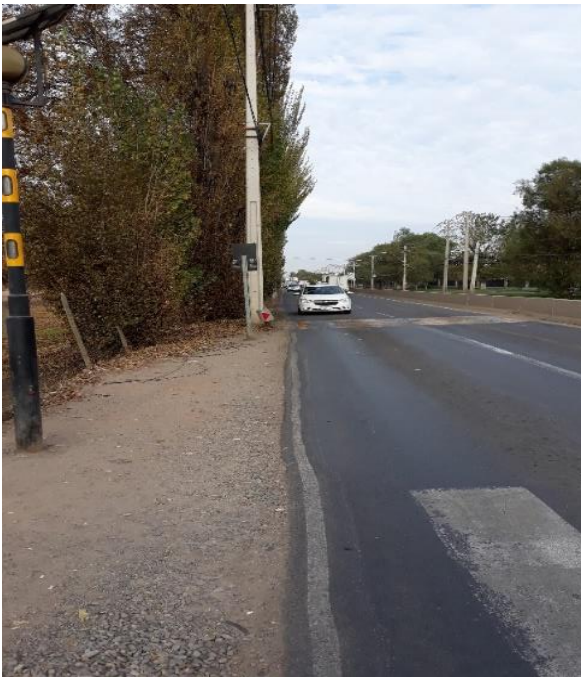
Limpieza y retiro de Basuras de la Faja
