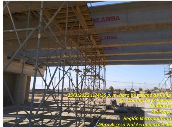
Colocación de moldajes inferiores para hormigonado de losa de Paso Superior Lo Marcoleta
