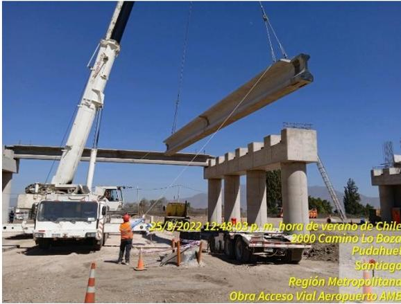
Montaje de vigas en Paso Superior Pudahuel Oriente (21 vigas en total)
