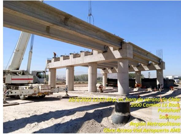
Otra vista de montaje de vigas en Paso Superior Pudahuel Oriente
