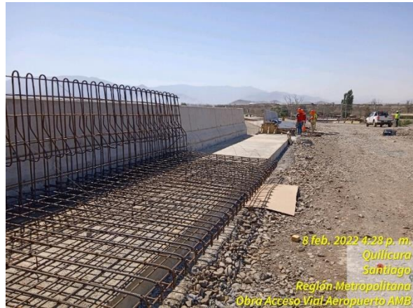
Enferradura para lateral de protección hecha in situ
