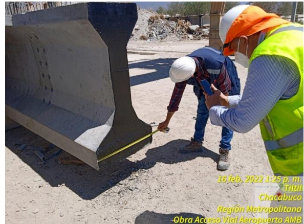
Verificación de geometría de vigas del Paso Superior Lo Marcoleta
