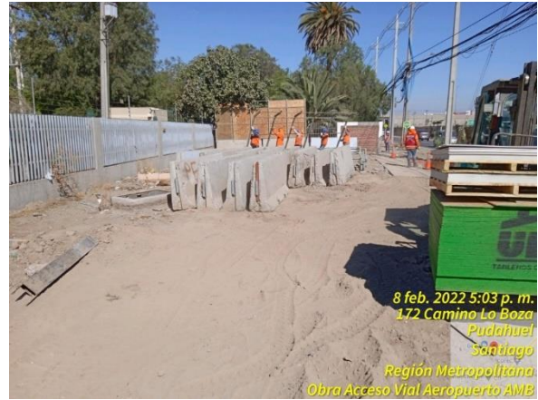
Instalación de pantalla para proteger del ruido por el exterior de Escuela Lo Boza
