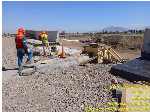
Cámara para recibir sumidero transversal sobre relleno de terraplén de acceso a PS Marcoleta
