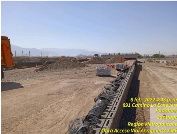
Armado de muro de bloques del muro TEM entrada a Paso Superior Lo Marcoleta
