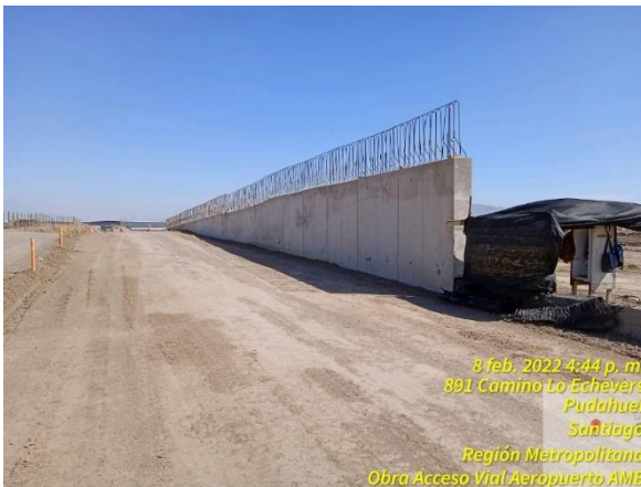
Muro de contención en hormigón convencional con armadura para construir barrera lateral
