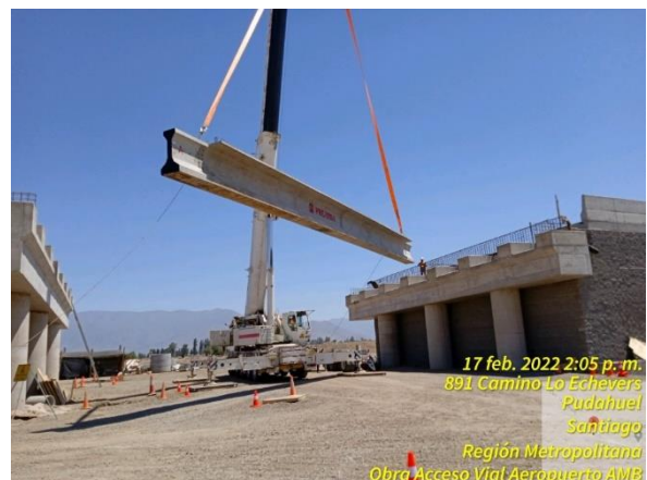
Preparación de grúa para montar viga en el Paso Superior Lo Marcoleta
