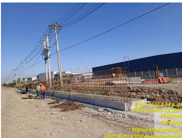
Muro de hormigón armado convencional en salida de Paso Superior Pudahuel Oriente
