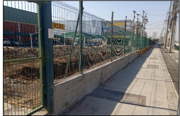
Remate línea cierre, sector Bodega Premier, dm 4.180
