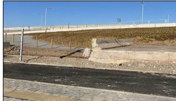
Plantío de cubresuelos en talud, dm 6.600 a 6.740
