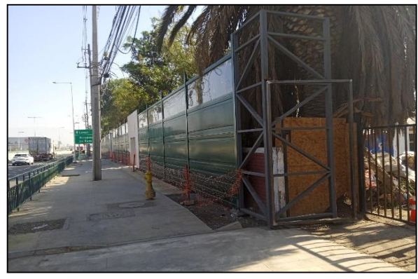
Instalación de Pantalla acústica, sector Escuela Lo Boza
