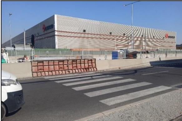
Continuidad barrera de hormigón mediana, dm 4.000
