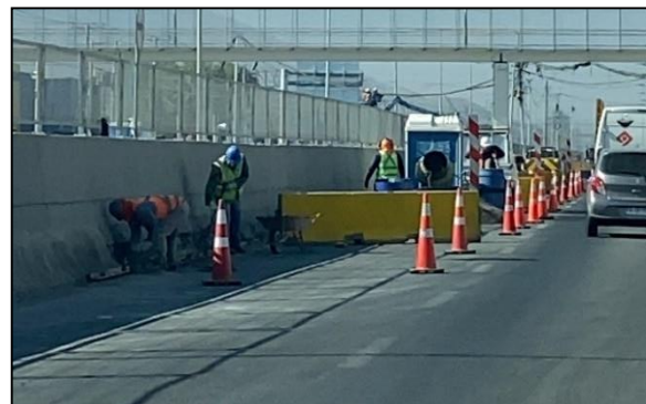
Reparación barrera de hormigón, sector pasarela V. Lascar
