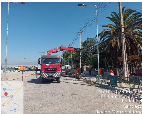
Retiro de Pantallas Acústicas Provisorias – Sector muro norte Escuela Lo Boza..
