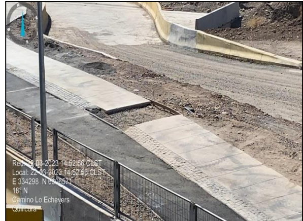
Reparación y Colocación de Adoquines y Aceras Sector Camino Lateral Norte 2.
