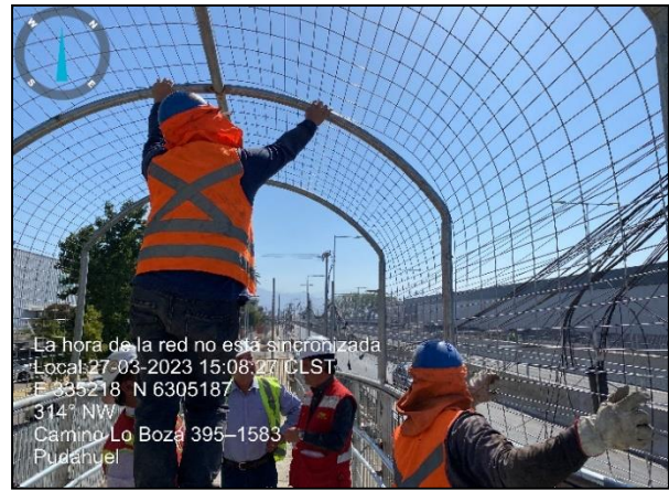
Trabajos en Pasarelas Cordillera y Volcán Lascar, instalación de cúpula de malla ACMA.
