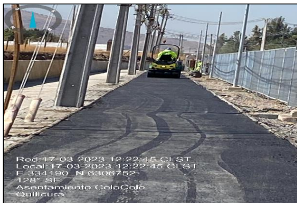
Asfalto en ciclo vía, dm 6.600 con conexión calle local N2.
