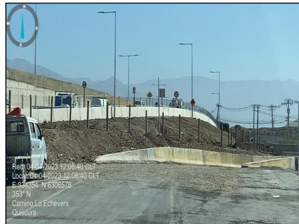
Instalación de rollizos de madera, por cerco de alambre de púas, sector Lo Echevers.
