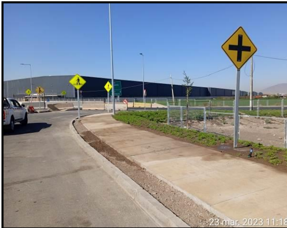
Instalación de señal vertical de advertencia de peligro en sector de Pudahuel Oriente, lado sur de Camino Lo Boza
