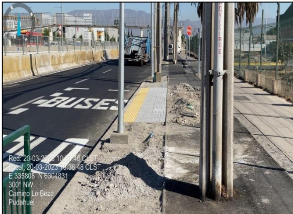
Construcción de Andenes para paradas de Buses.
