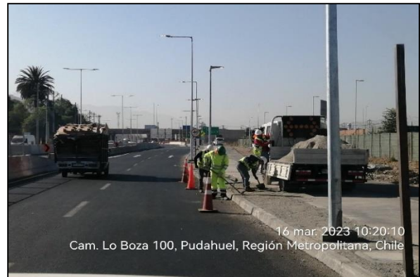
Trabajos de Paisajismo. Colocación de maicillo, camino Lo Boza 100.
