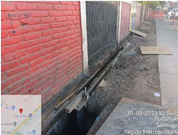
Excavación, para fundaciones de pantallas acústicas en frontis escuela Lo Boza.
