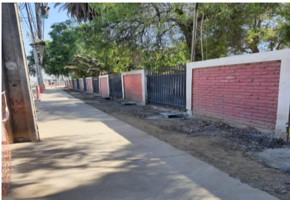
Fundaciones de pantallas acústicas, en frontis Escuela Lo Boza.
