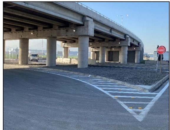
Paso Superior Pudahuel Oriente
