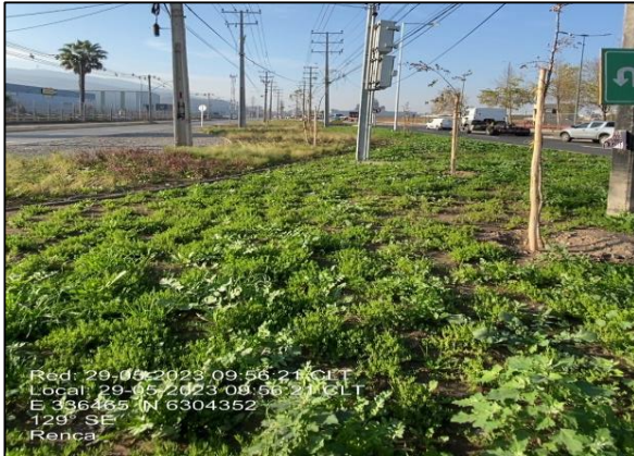
Colocación de cubresuelos en Eje Condell
