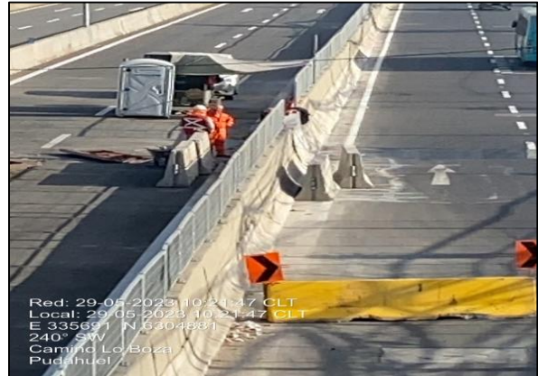
Cierre barreras de hormigón en paso peatonal provisorio
