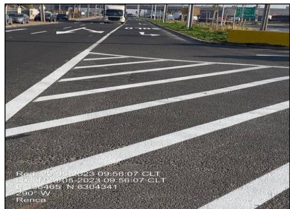
Demarcación de pavimento, sector Eje Condell
