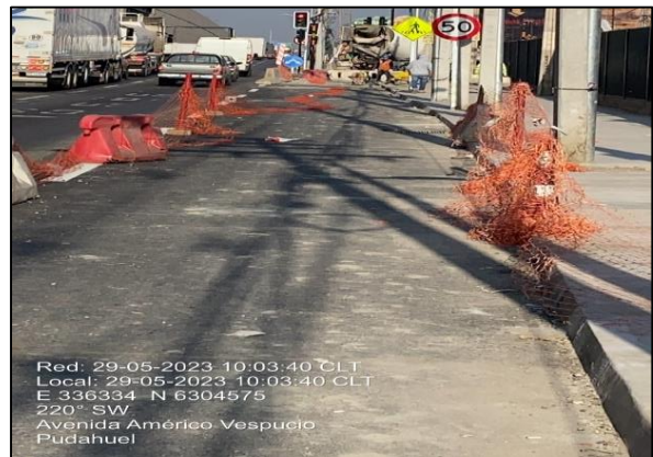
Trabajos viales sobre carpeta asfáltica en Ramal 1
