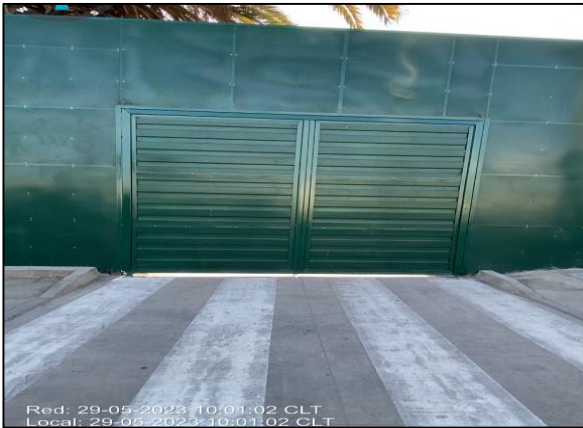
Instalación Pantalla acústica, frontis Escuela Lo Boza
