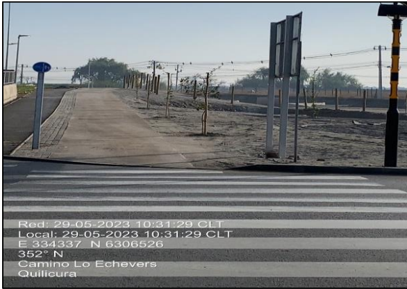
Instalación Cerco especial, sector calle lateral Norte 2
