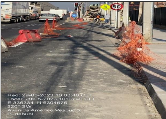
Trabajos viales sobre carpeta asfáltica en Ramal 1
