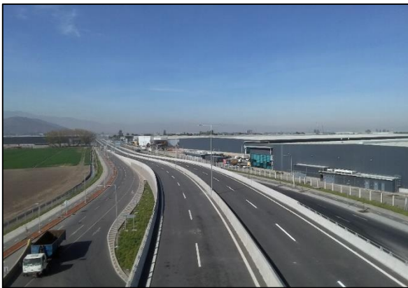
Vía expresa / calle lateral Norte, dm 5.600 aprox.
