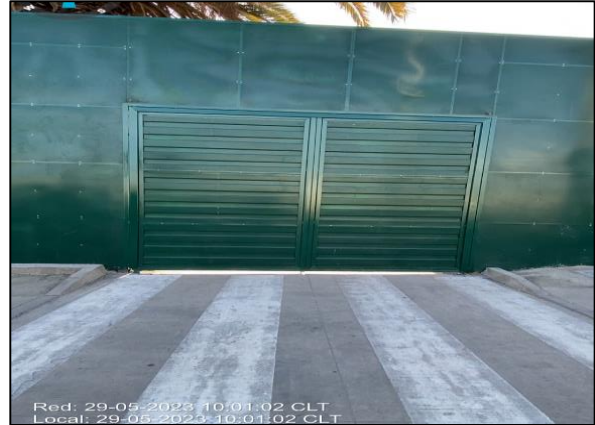
Instalación Pantalla acústica, frontis Escuela Lo Boza
