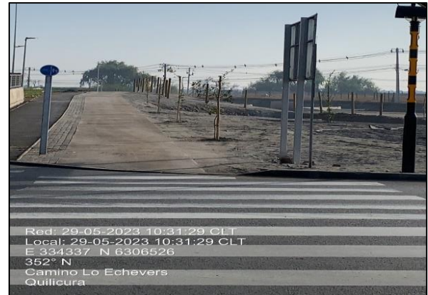
Instalación Cerco especial, sector calle lateral Norte 2
