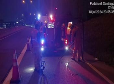
AMB. Km. 2,000 ascendente, Lazo 1; Sello de grietas carpeta asfáltica.
