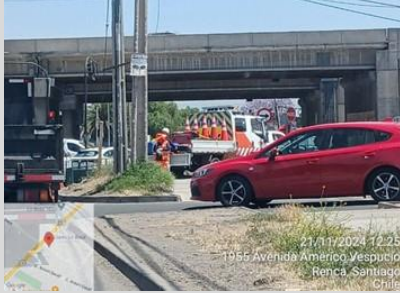
AMB. Km. 3,500 Lo Boza; Reparación de barrera en vía local.
