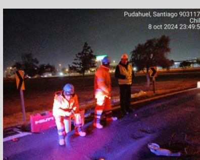
Km. 0.600 mantención estructura
