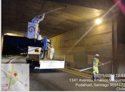
AMB. Km. -0,100 Ascendente; Tratamiento eflorescencias en cajón, Lazo Interior Nororiental.
