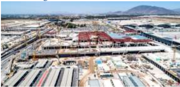
Vista general de la Obra enero 2019
