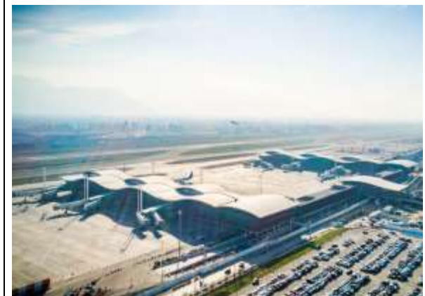
Pronta entrega del espigón E. Solo trabajos de terminación y reparaciones menores
