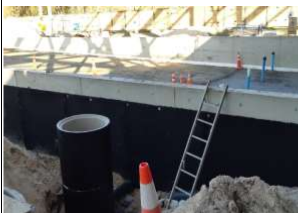
Vista O-P. Prueba de hermeticidad en cámaras de alcantarillado, sector de la Rampa sur
