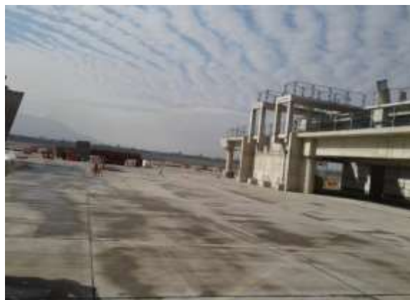
Espigón D: Calle de servicio lado Sur
