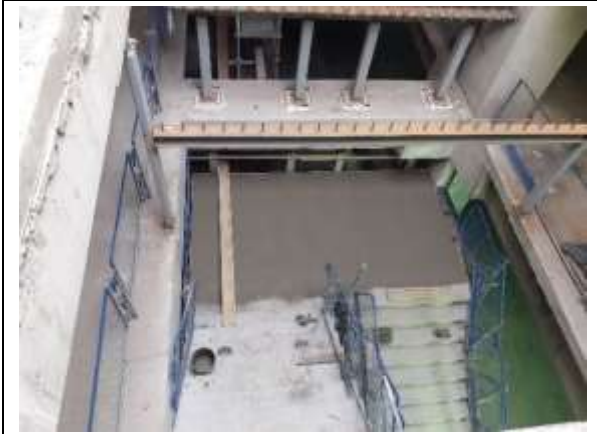
Cuerpo B: Montaje de escaleras 13 y 14
