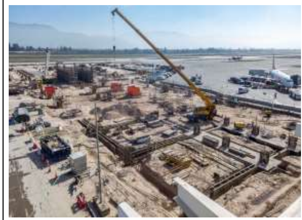
T1A, finalización en la ejecución de pilotes
