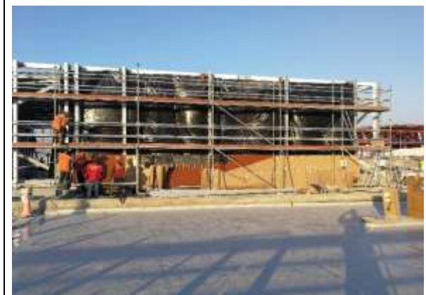
Ejecución de Revestimiento exterior para sala de exposición Nivel cubierta
