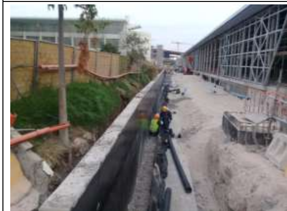
Muro explanada central frente a módulo 1
