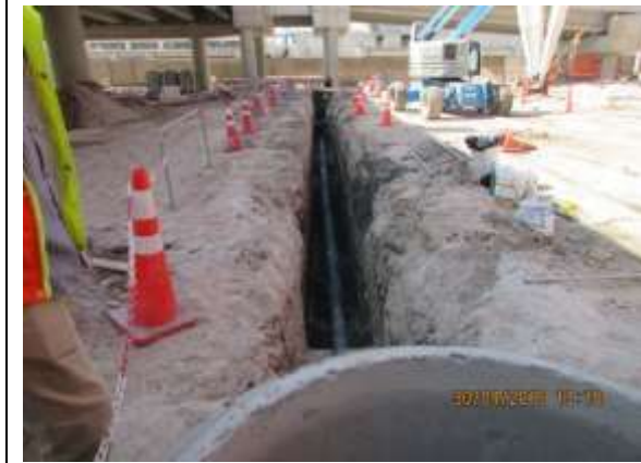
Instalación Tubería Red Exterior Enterrada Drenajes Aguas Lluvias PVC. 250 mm.
