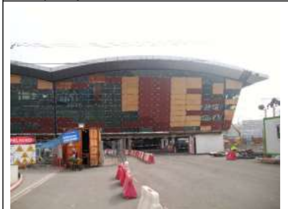
Instalación vidrios faltantes en fachadas.
