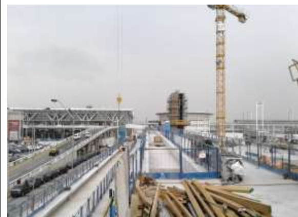
Corredor DB, nivel 3 avance, Vista de Sur a Norte.
