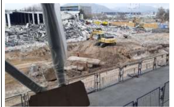
Vista S-P lado sur espigón F. Excavación y Relleno sector cercano a Espigón F.
