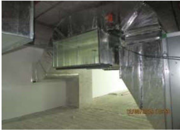
Nivel 2: Montaje de ductos de aire en T2M
