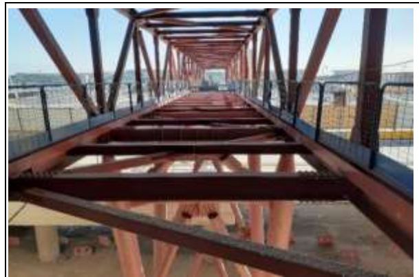
Trabajos en pasarela norte cuerpo H
