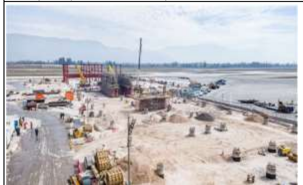
Obras Civiles en T2A.
