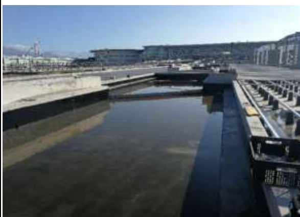
Prueba de inundación para Impermeabilización Módulo C. Estacionamiento Superficie Poniente.
