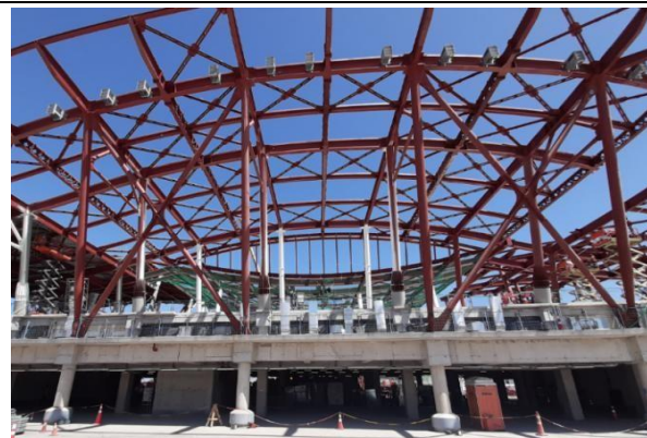
T2D: Vista general del avance del nivel 3 del espigón.
