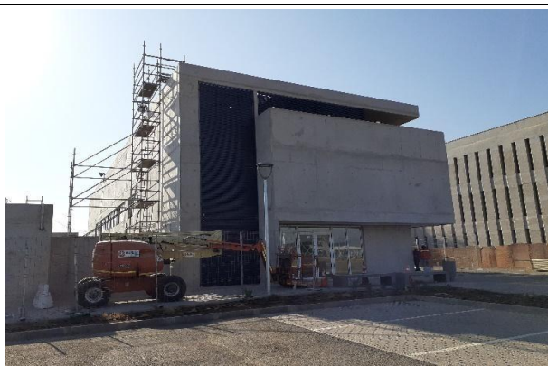
Edificio PDI: Detalle de fachada poniente y colocación de celosías.
