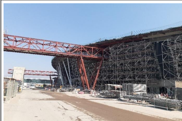
Vista fachada sur del T2M y Pasarelas
