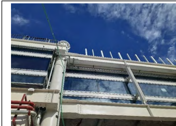
T1A: .- Instalación de tubería para sistema diluvio.
