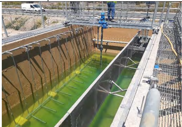
PAS: Llenado con agua potable en Estanque Desarenador y Desgrasador
