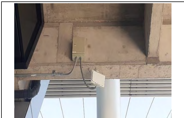
T2M: Inspección Sistema WiFi Interior en T2M.
