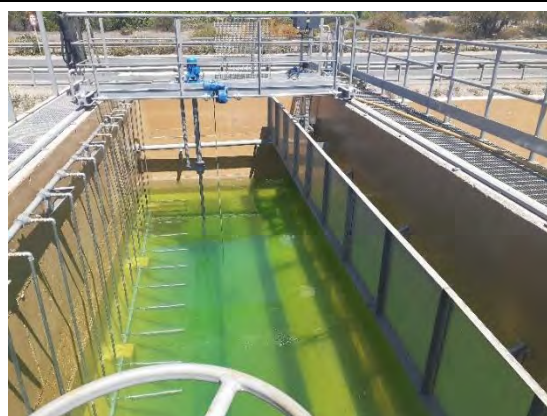
PAS: Llenado con agua potable en Estanque Desarenador y Desgrasador
