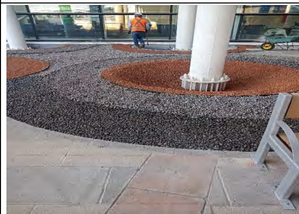
T1 (terminal actual): arreglos en entrada principal.
