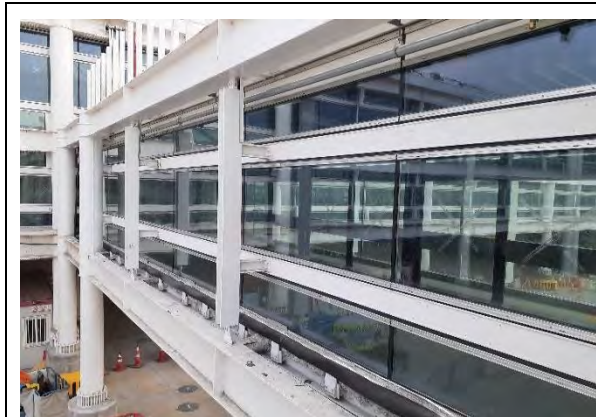
T1A: Vista general fachada pre-puentes.
