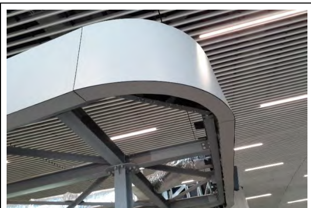
T2M: Detalle de revestimientos
