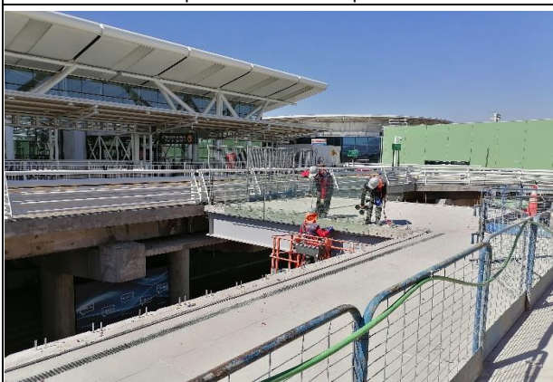
ESO: Instalación cristal pasarela a conexión viaducto T1 04.02.2021
