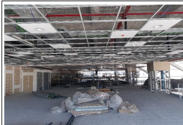
T1A: Vista detalle de cielos del tipo americano en tercer nivel.
