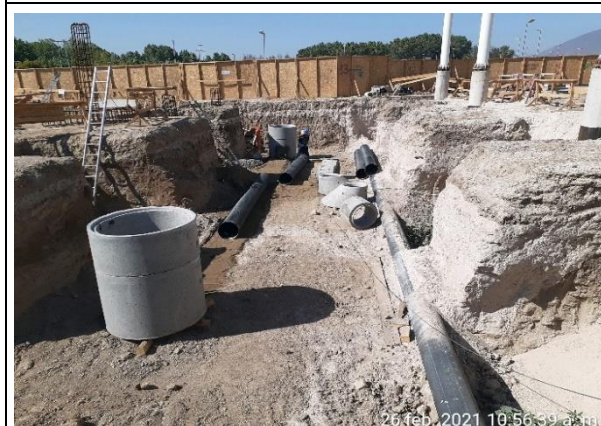
ZPB: Excavaciones Bypass Dren.
