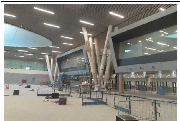
T2M: Vista general de fachadas de cajas VIP de cuarto nivel.
