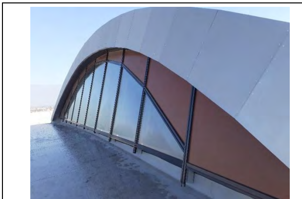
T2M: Caminata revisión de cubierta y lucernarios.
