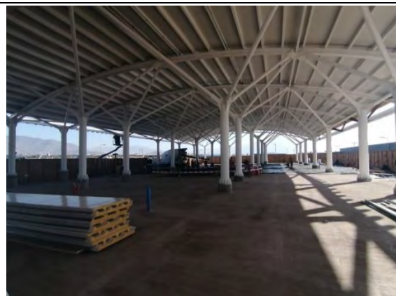
ZPB: Vista general del avance de la estructura metálica.
