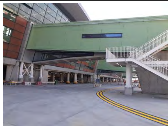
Espigón F: Pintura señalética airside, lado sur.
