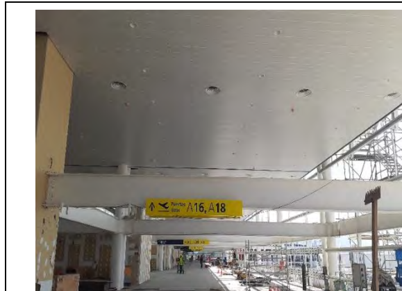
T1A: Vista instalación de letreros de información.
