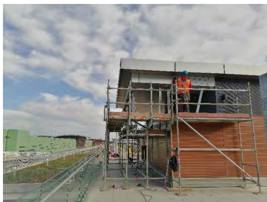
ESO: Instalación de ACM en comercio en cubierta cuerpo A
