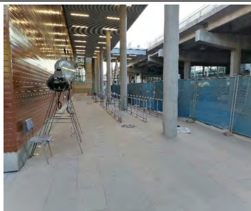
ESO: Instalación de estructuras metálicas.
