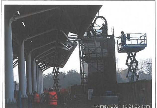
ZPB: Instalación de cubierta.
