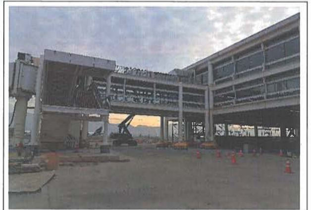
T1A: Vista exterior fachada sur
