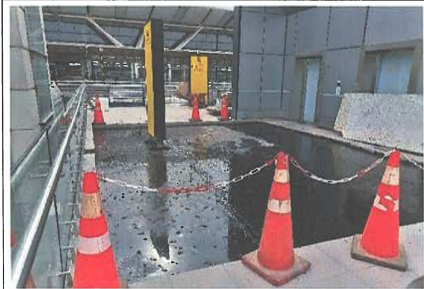
ESO: Inicio de trabajos de corrección en pendiente de pavimento.
