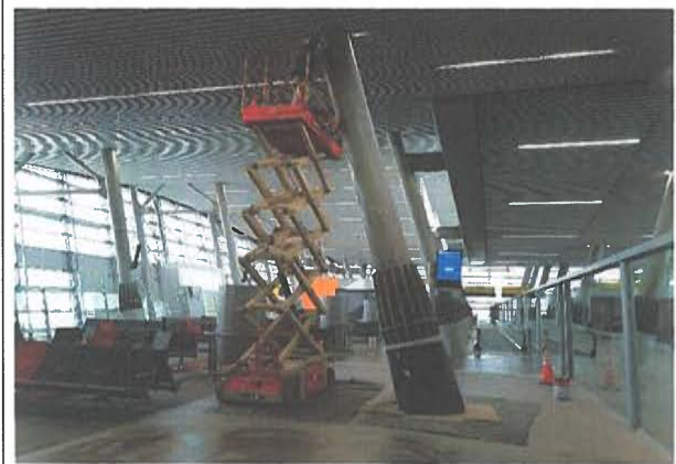
Espigón D: Pintura de terminación en pilares estructurales.
