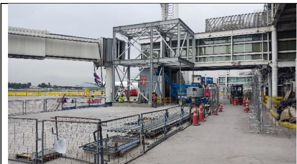
Continúa montaje de EEMM PBB18 subcontrato Ducars.
