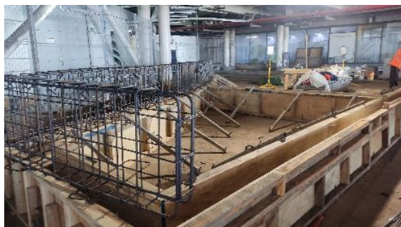
Ejecución de muretes en sector Bodega Zona Poniente.
