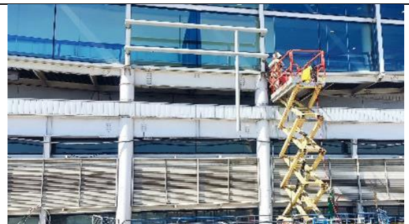
Instalación estructura VDGC.
