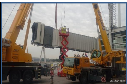
Lado Aire Sector Norte. Trabajos de retiro de manga de embarque 18 por empresa Tianda.
