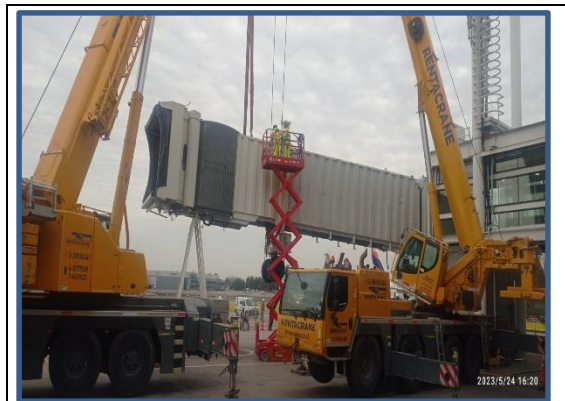
24/05/2023, Lado Aire Sector Norte. Trabajos de retiro de manga de embarque 18 por empresa Tianda.
