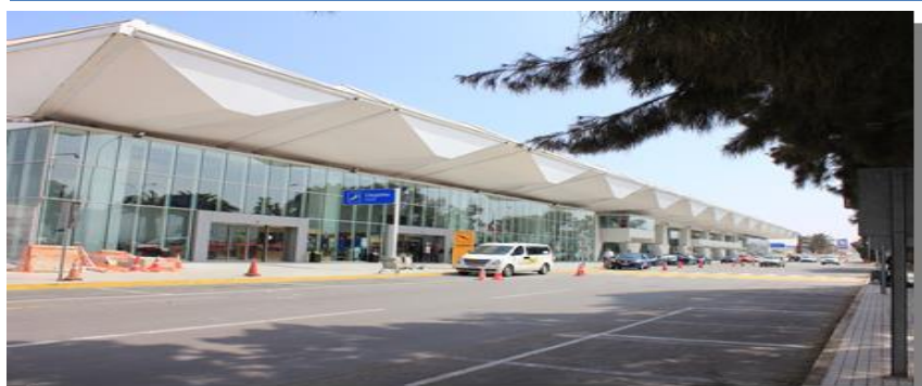
Figura 1: Frontis Edificio Terminal Aeropuerto Cerro Moreno.
