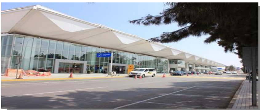
Figura 1: Frontis Edificio Terminal Aeropuerto Cerro Moreno.
