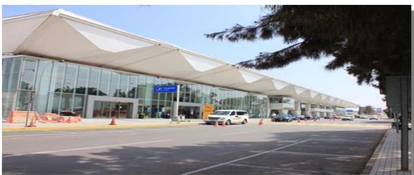
Figura 1: Frontis Edificio Terminal Aeropuerto Cerro Moreno.
