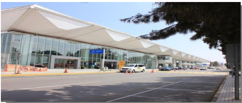
Figura 1: Frontis Edificio Terminal Aeropuerto Cerro Moreno.
