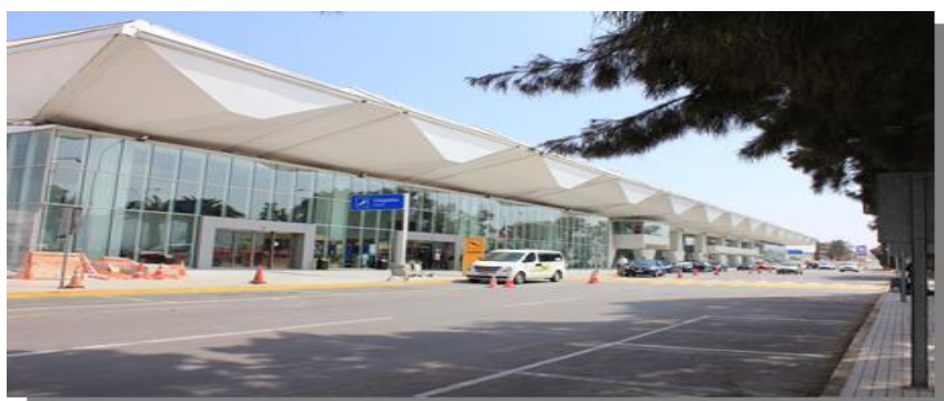
Figura 1: Frontis Edificio Terminal Aeropuerto Cerro Moreno.
