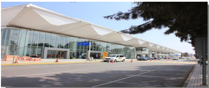
Figura 1: Frontis Edificio Terminal Aeropuerto Cerro Moreno.
