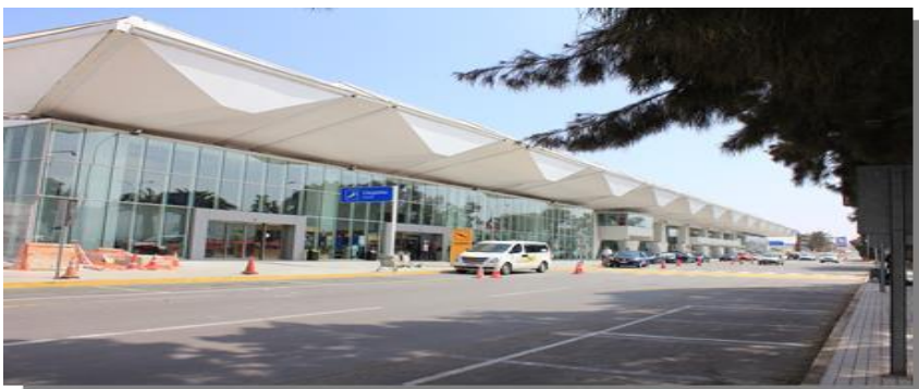
Figura 1: Frontis Edificio Terminal Aeropuerto Cerro Moreno.
