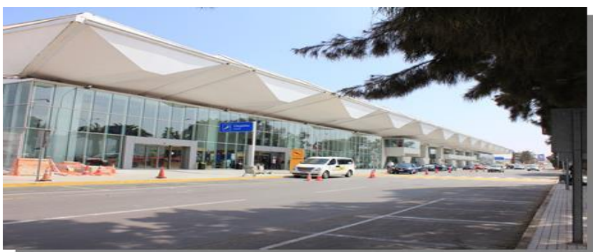
Figura 1: Frontis Edificio Terminal Aeropuerto Cerro Moreno.
