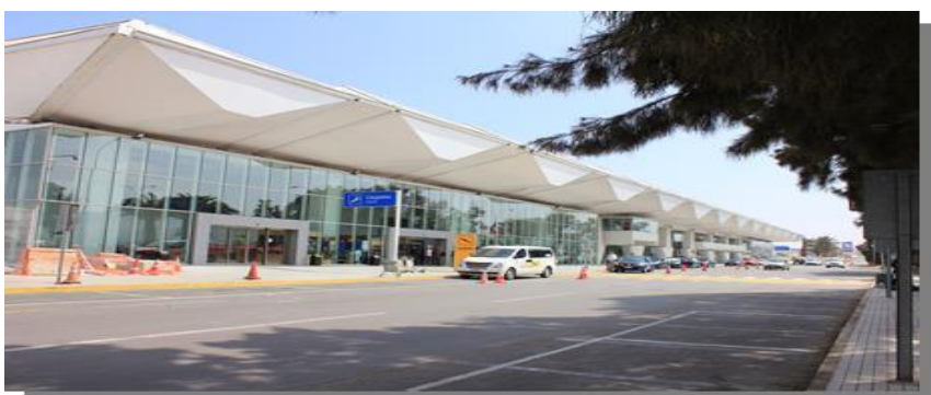
Figura 1: Frontis Edificio Terminal Aeropuerto Cerro Moreno.
